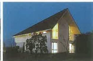
啓明今井会館 (校友会館) 2010年3月31日竣工 友人は生涯の空
